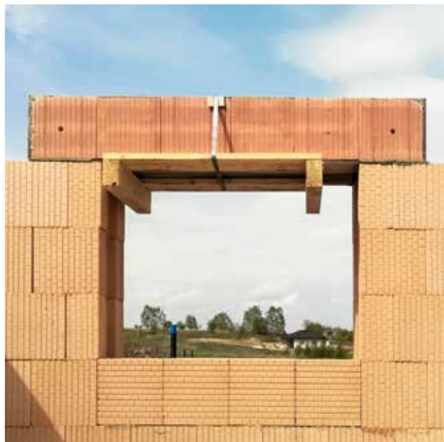
② Pohľad na uloženie prekladu z vnútornej časti budovy. Paleta sa tesne po osadení prekladu jednoducho zloží.
