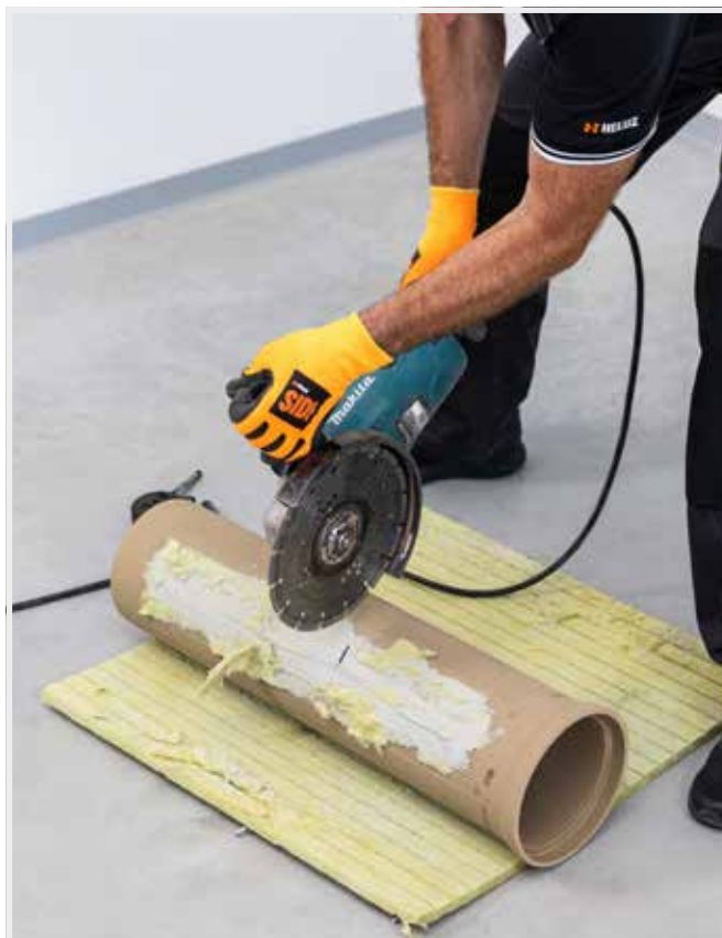
VLOŽKY SA REŽÚ UHLOVOU BRÚSKOU S VHODNÝM KOTÚČOM
