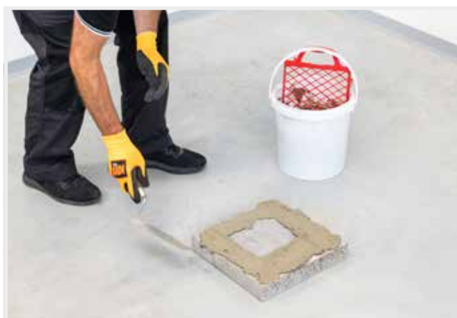
NANESENIE MUROVACEJ MALTY
