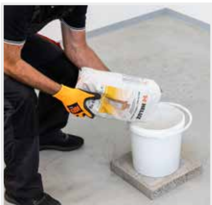
ROZMIEŠANIE MUROVACEJ MALTY
