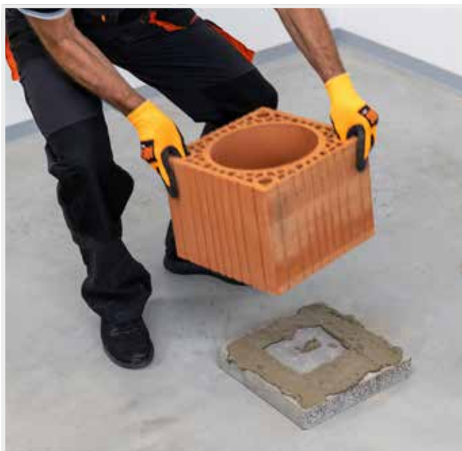
OSADENIE PRVEJ KOMÍNOVEJ TVAROVKY A JEJ PRESNÉ VYROVNANIE
