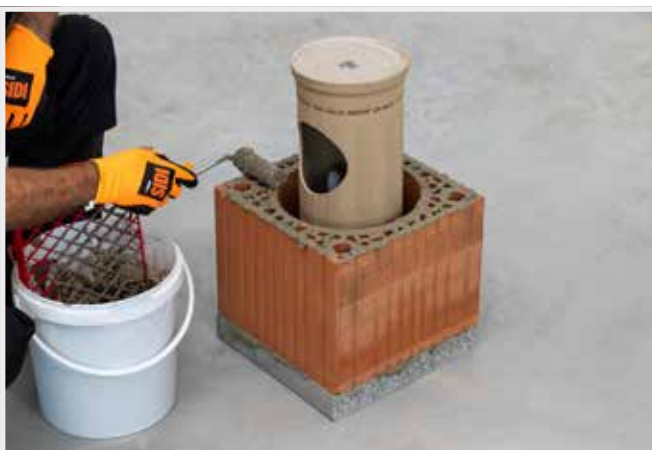
NANÁŠANIE MUROVACEJ MALTY NA LOŽNÚ ŠKÁRU
