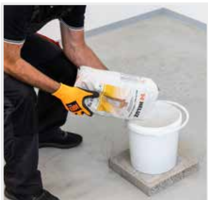
ROZMIEŠANIE MUROVACEJ MALTY
