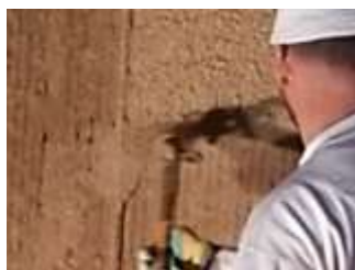
Obr. 6 – Strojní nanášení omítky
