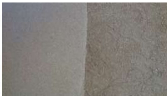
Obr. 9 – Jemná omítka na jádrové omítce
