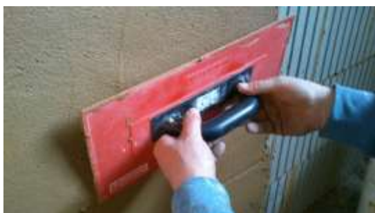
Obr. 8 – Natahování omítky hladítkem
