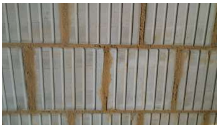
Obr. 2 – Promaltování vodorovných i svislých spár
