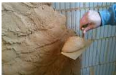
Obr. 5 – Ruční nanášení omítky
