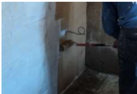
Obr. 3 – Nanášení spojovacího můstku válečkem
