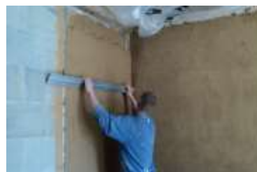
Obr. 7 – Stahování omítky latí
