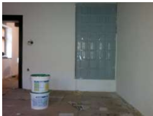
Obr. 11 – Hliněné omítky po provedení nátěru
