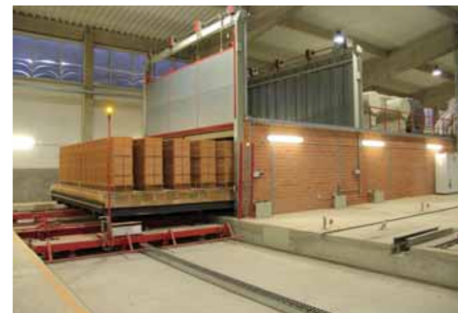
Sušení a pálení: Cihly se nejdříve suší při teplotě do 100 °C po dobu asi 16 hodin. Poté se v překladišti sušených cihel přeloží z pásu na pecní vůz, který je zaveze do pece, kde se vypalují při teplotě 890 °C. Průjezd pecí trvá dalších 16 až 17 hodin. Celý proces je maximálně energeticky optimalizovaný. K sušení se používá odpadní teplo z pece.
