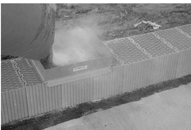
Sypání perlitu do maltovacího přípravku.
