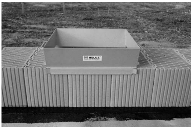
První vrstva cihel připravená pro zasypání perlitem.
